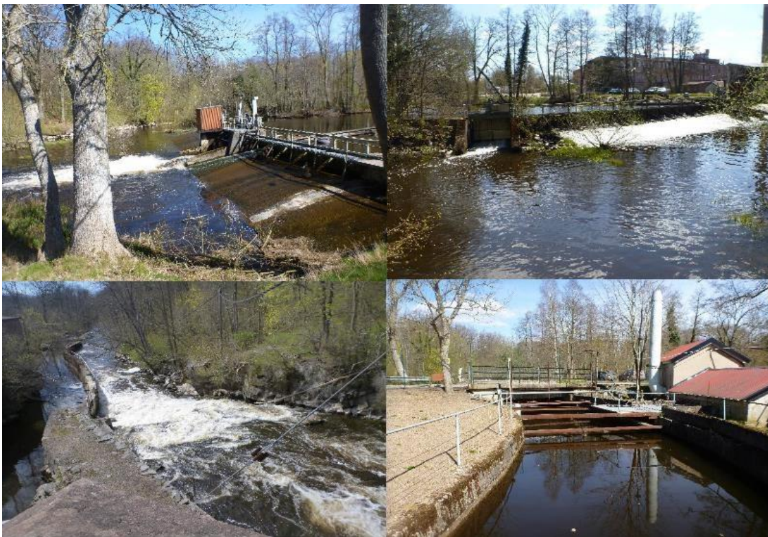
Figur 7. Klippan, de översta bilderna visar befintliga dammen. Nedan t v är forsen nedströms bron och nedan t h är turbinkanalen inne på bruket.
