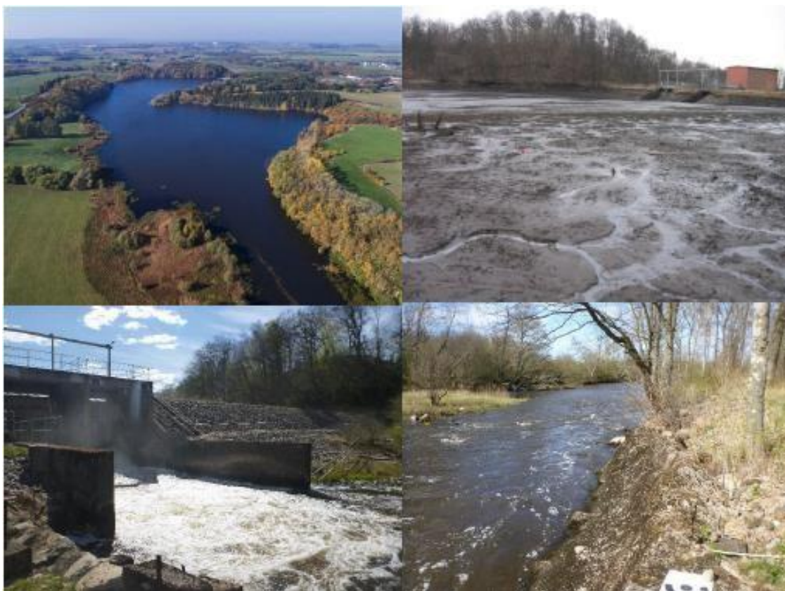
Figur 10. Stackarp, överst t v flygfoto över dammen, överst t h vid avsänkning 2009, nedan t v utskov, nedan t h nedströms damm och kraftverk.
