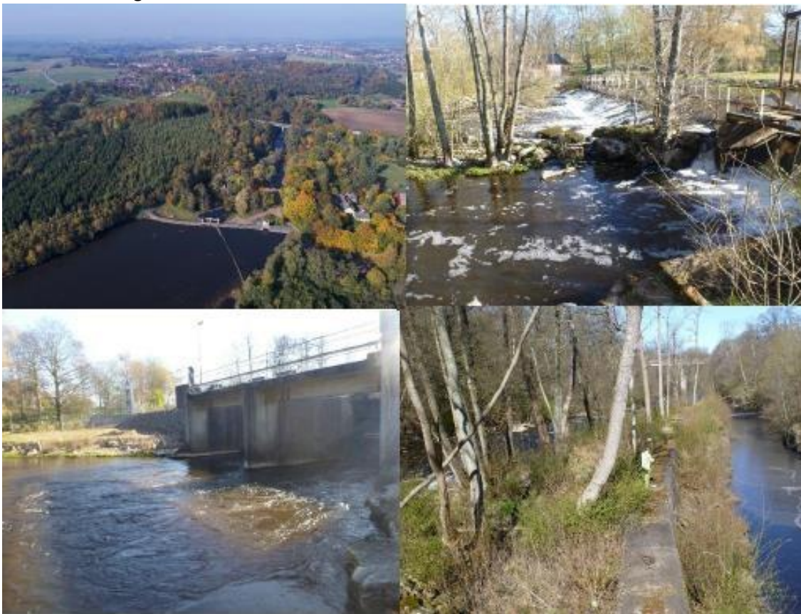
Figur 4. Forsmöllan, överst t v flygfoto över dammens nedre del, överst t h gamla dammvallen, nedan t v utskov, nedan t h nedströms damm och kraftverk.
